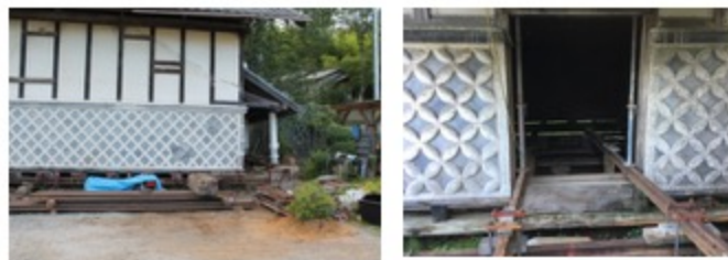
曳家の準備としてジャッキアップされた蔵、外観・内部の様子
